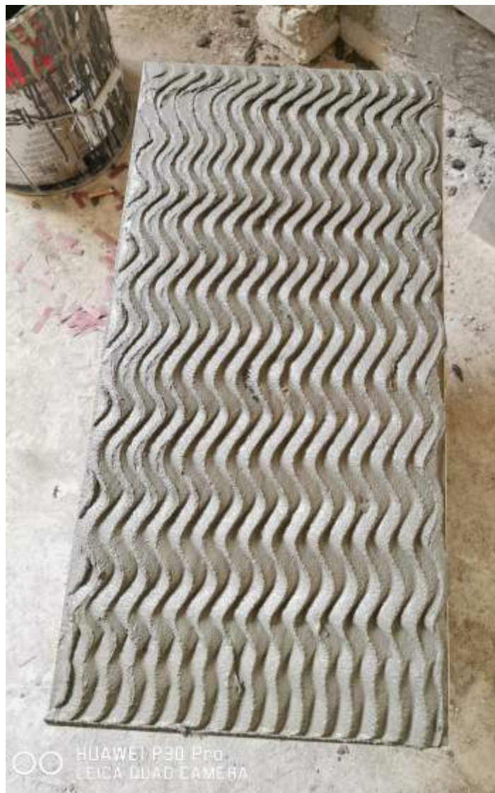
防水型瓷砖胶薄贴工艺
