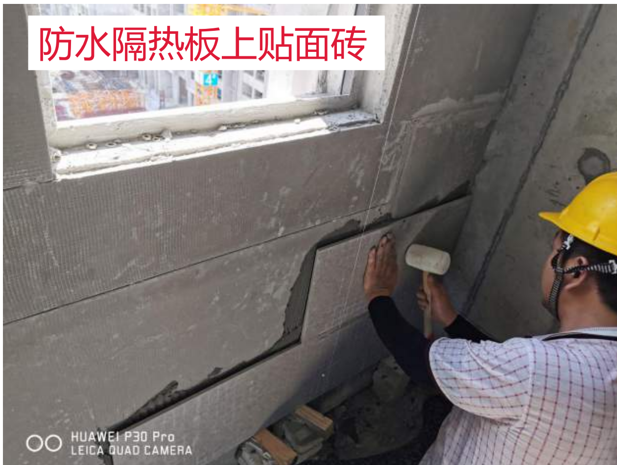
防水型瓷砖胶粘贴面砖分层展示
