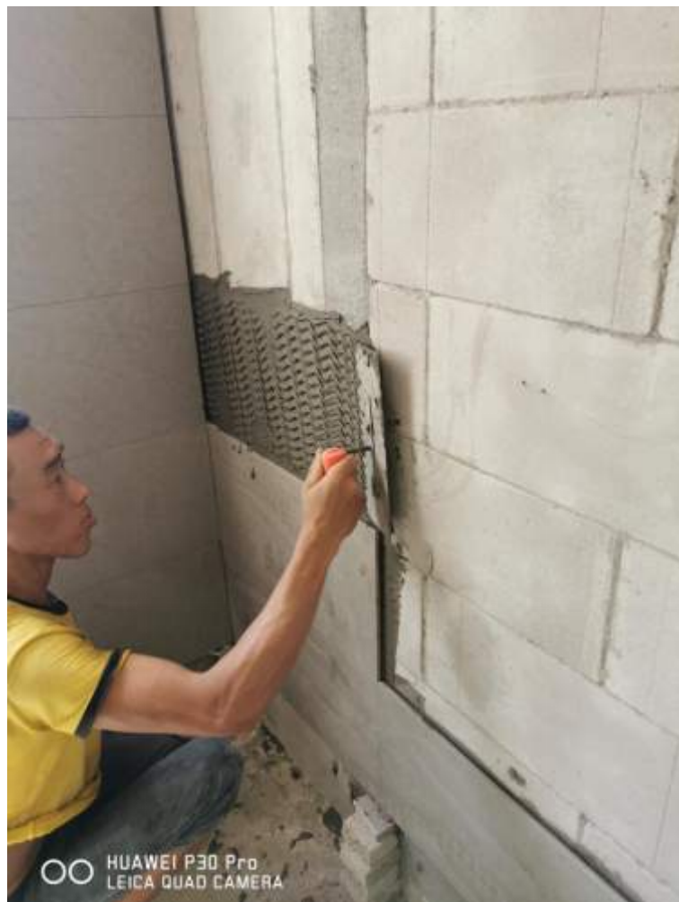
防水型瓷砖胶薄贴工艺
